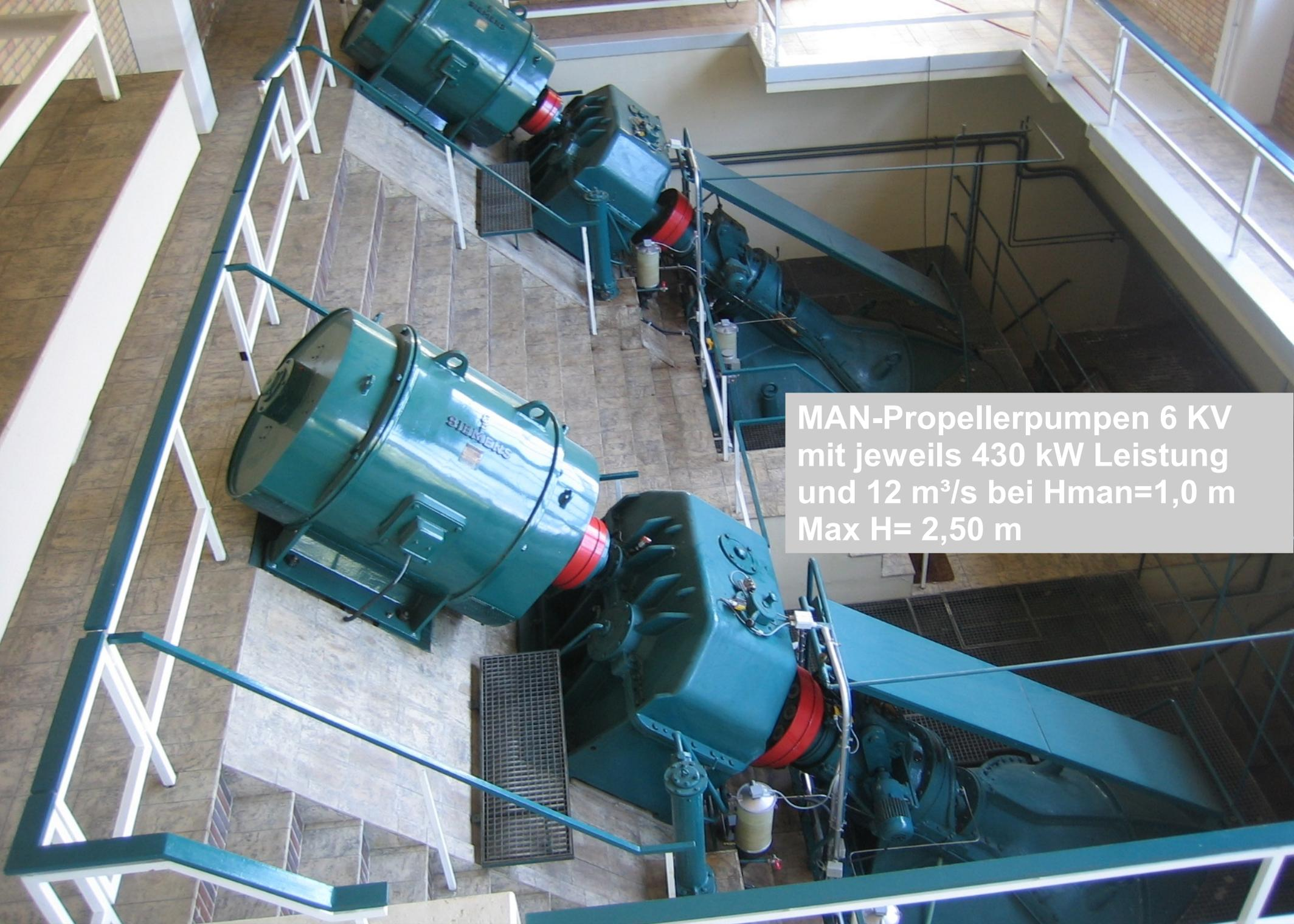
MAN-Propellerpumpen 6 KV
