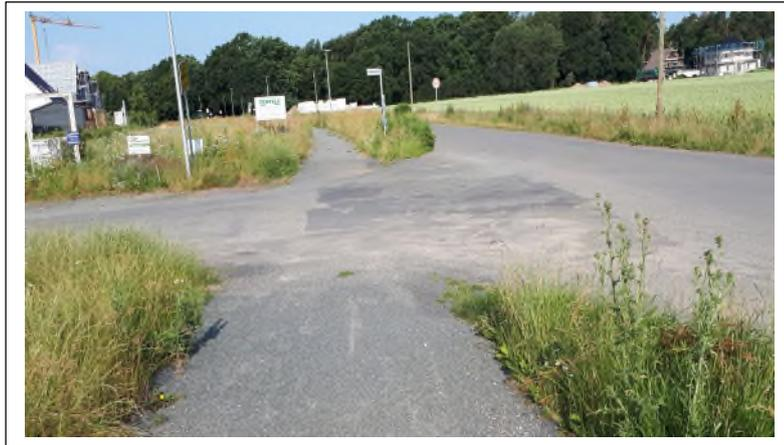
Der Bahnweg in Zetel/Bockhorn besteht aus einer einfachen Splittschicht auf Schotter (siehe Foto).
