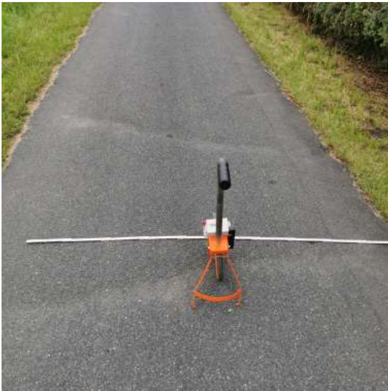
Bild 17 (Foto: Schmidt) Station +582 Querrinnen
