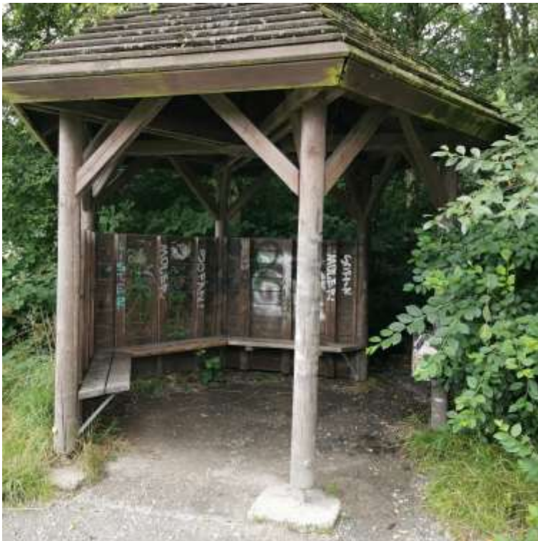
Bild 2 (Foto: Schmidt) Station +20 Pausenhäuschen
