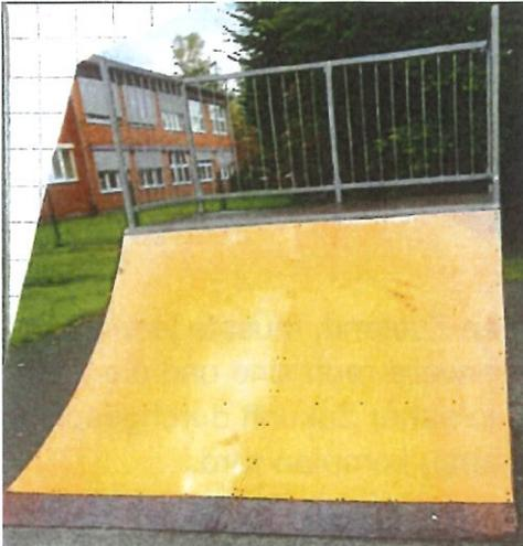
Der Anfahrbereich ist bereits korrodiert, sodass die Aufnahme der häufig gebrochenen Schrauben ohne Unterfütterung nicht mehr möglich ist. Der Bereich unter der Brüstung ist nicht, wie von der DIN geforderte  $<6$  cm, sodass auch dies laut DEKRA verändert werden müsste.
