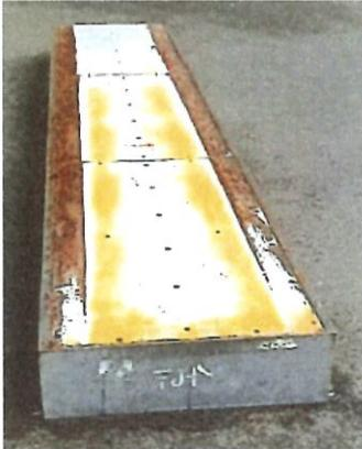
Die Curb ist noch in einem ausreichenden Zustand, müsste jedoch überarbeitet werden, da die Kanten mittlerweile rau sind und die Oberfläche der Siebdruckplatten sicher in naher Zukunft durchgescheuert ist und es dann zu Bruchstellen (s. Miniramp) kommen wird.
