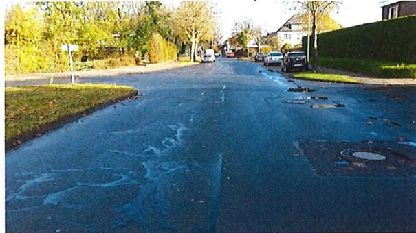
Abbildung 1: Risse Asphalt, Versackungen, schadhafte Schächte
