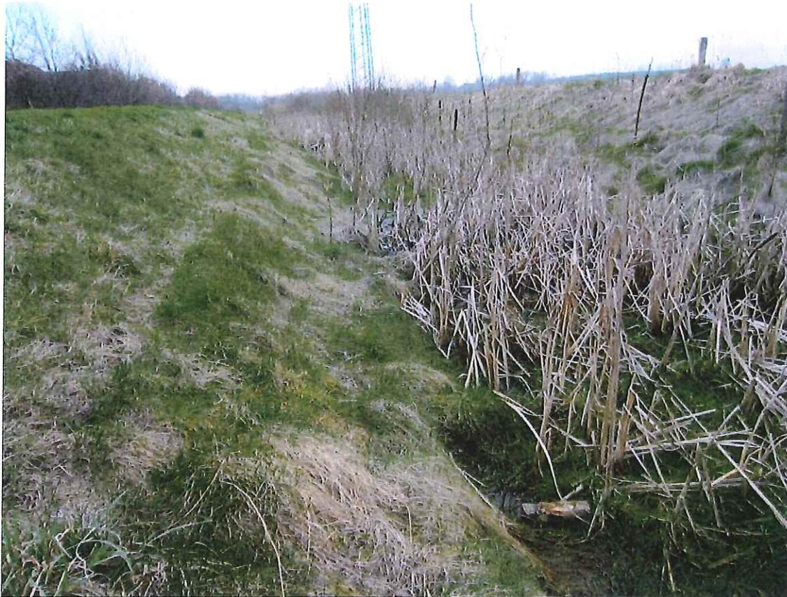
RHB Baug. in Sande. Hier wurde 2007 / 2008 dummerweise sogar vom Planungsbüro Rohrkolben eingesetzt. Die Probleme werden kommen!
