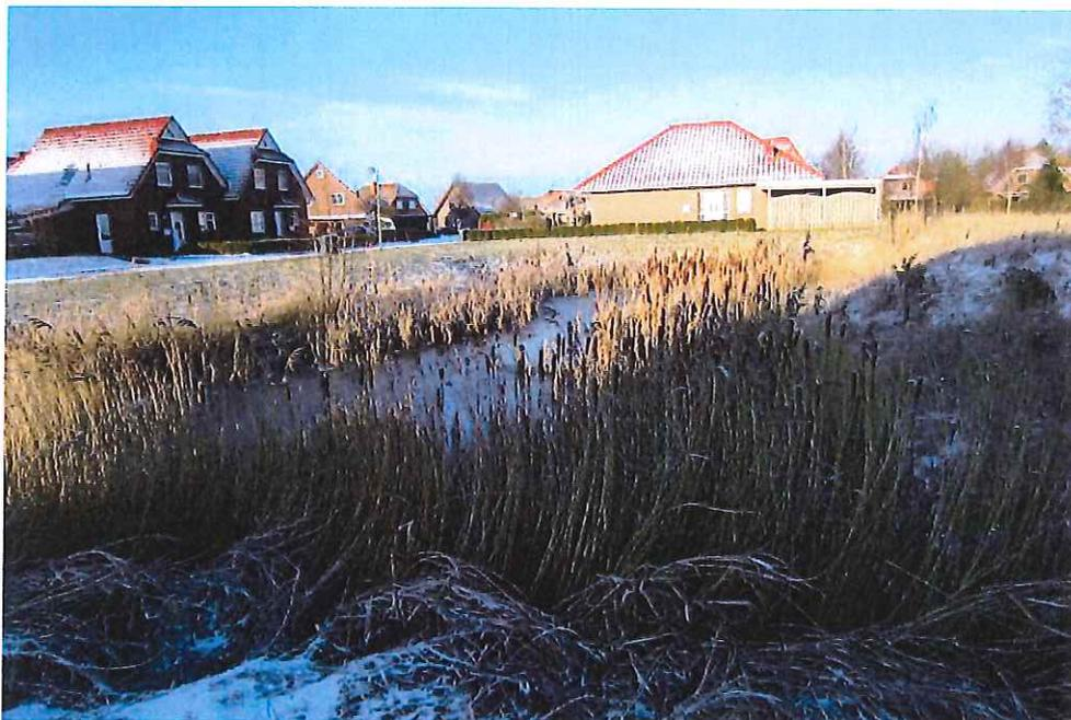
Das RHB Baug. 35B Am Schwarzen Brack , Baujahr 2003, wurde schnell ein Opfer unbekannter Rohrkolbenliebhaber. Nach einer aufwendigen Abtragung mittels Bagger ist es wieder dicht, die Wurzeln (Rhizomen, über- wie im Erdreich wachsend) sind nicht mehr ausreichend zu entfernen.
